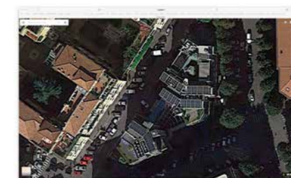
Fig. 66 - La foto aerea mostra l'integrazione delle tettoie fotovoltaiche nel disegno dell'edificio
