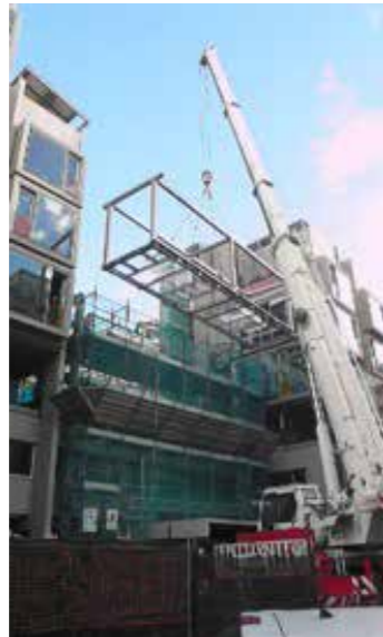
Il varo della struttura del ponte. Il ponte completato. Un momento emozionante per tutte le persone coinvolte nel progetto.
