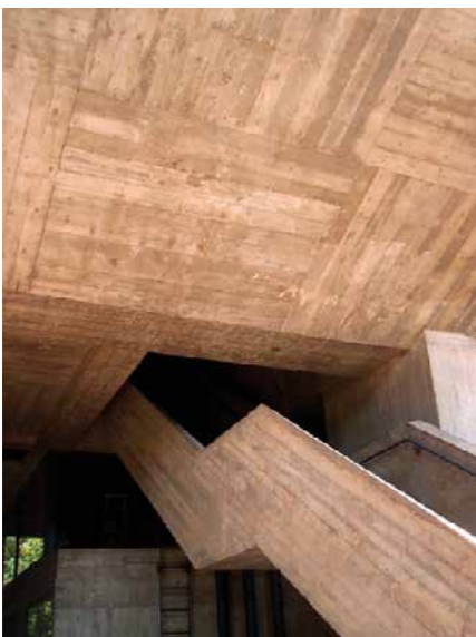
Fig. 33 - Un disegno dello studio di Le Corbusier del basamento dell'unità d'abitazione di Marsiglia e una foto dello stato attuale. La disposizione delle tavole della cassaforma non è lasciata al caso ma fa parte dell'ideazione architettonica.
