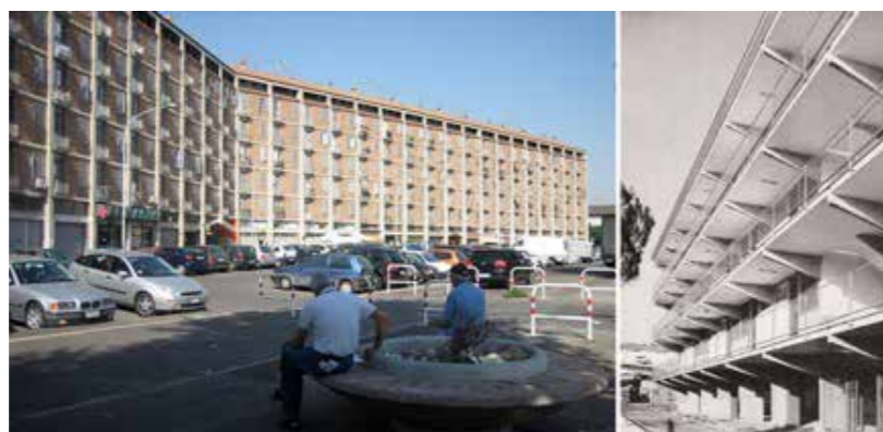
Fig. 3 - Residenze INA Casa, quartiere Tuscolano, Roma, edificio a sinistra, Arch. Muratori, De Renzi, a destra, Arch. Libera. Nelle case alte (torri, edifici in linea) la struttura portante è costituita da un telaio in cemento armato, e riempimento in muratura. Il telaio può, come in questi esempi, evidenziarsi in facciata.
