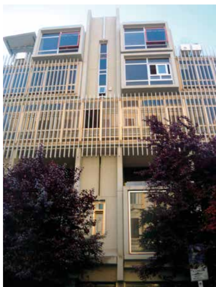
Fig. 68 - L'edificio B nel 2012 prima dei lavori, gli infissi sono alcuni originali molti già sostituiti
