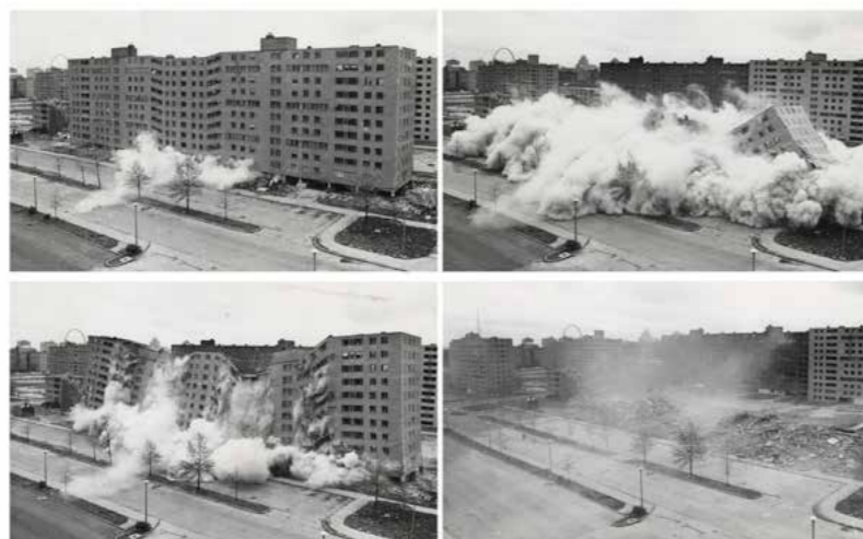
Fig. 8 - La demolizione del quartiere Pruitt-Igoe nel 1972.
