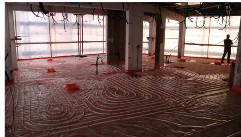
Fig. 93 - La posa delle tubazioni del pavimento radiante, sono visibili le torrette per le prese elettriche a pavimento e le fasce di PET espanso alla base dei pilastri
