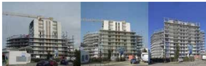
Fig. 12 - Un'azione che mai demolisce, sottrae o sostituisce parti dell'edificio, ma sempre aggiunge, trasforma o riutilizza. La Chesnaie, Saint-Nazaire, progetto di Lacaton e Vassal.
