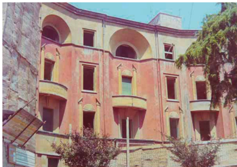
Fig. 26 - Il Villino di Del Debbio durante la demolizione nei primi anni '70
