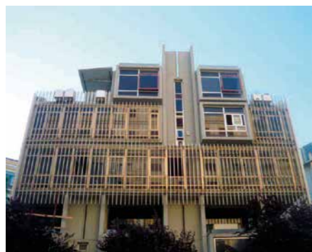
Fig. 32 - L'edificio prima dei lavori
