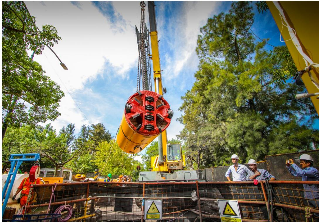
Los Ghella normalmente montan la máquina sobre el terreno, para poderla adaptar mejor a las características del terreno y garantizar un trabajo impecable. Los diferentes componentes mecánicos son producidos por los fabricantes, siempre según las especificaciones indicadas por los ingenieros de Ghella, y se transportan al lugar de la obra.
