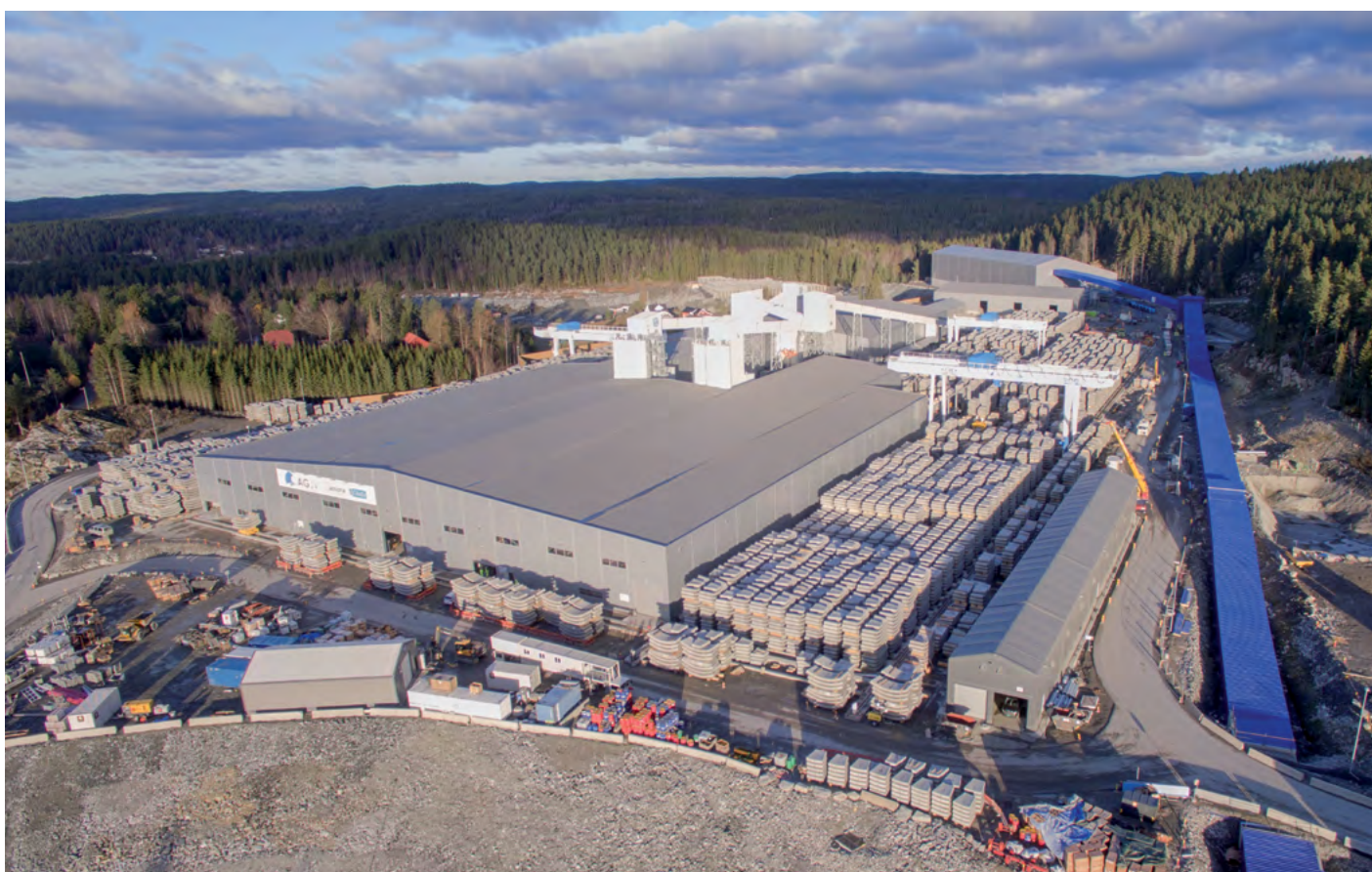
Norvegia, Oslo - Progetto ferroviario Follo Line
